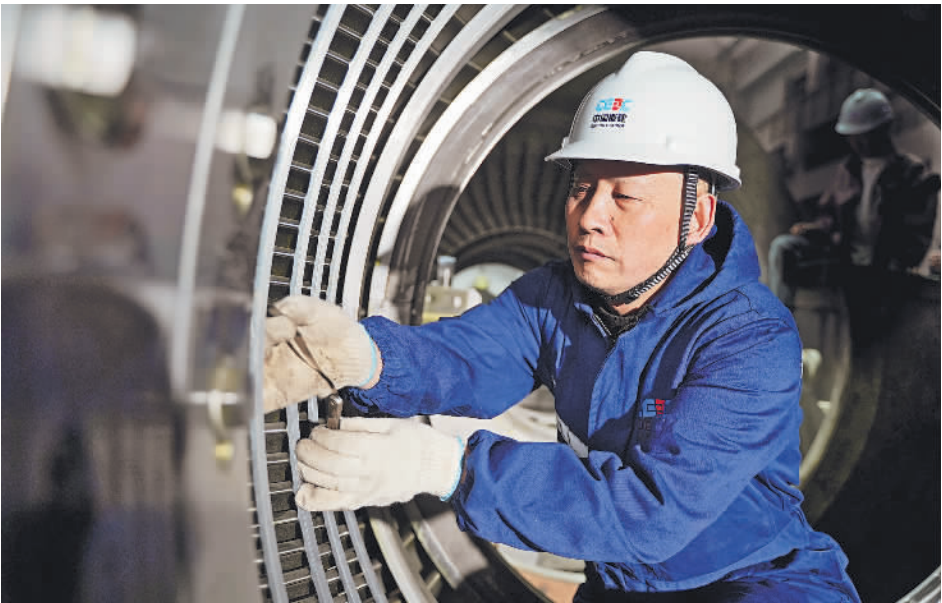
王怀祥在甘肃电投张掖电厂对内部套安装质量进行验收。 中国能建建筑集团供图
